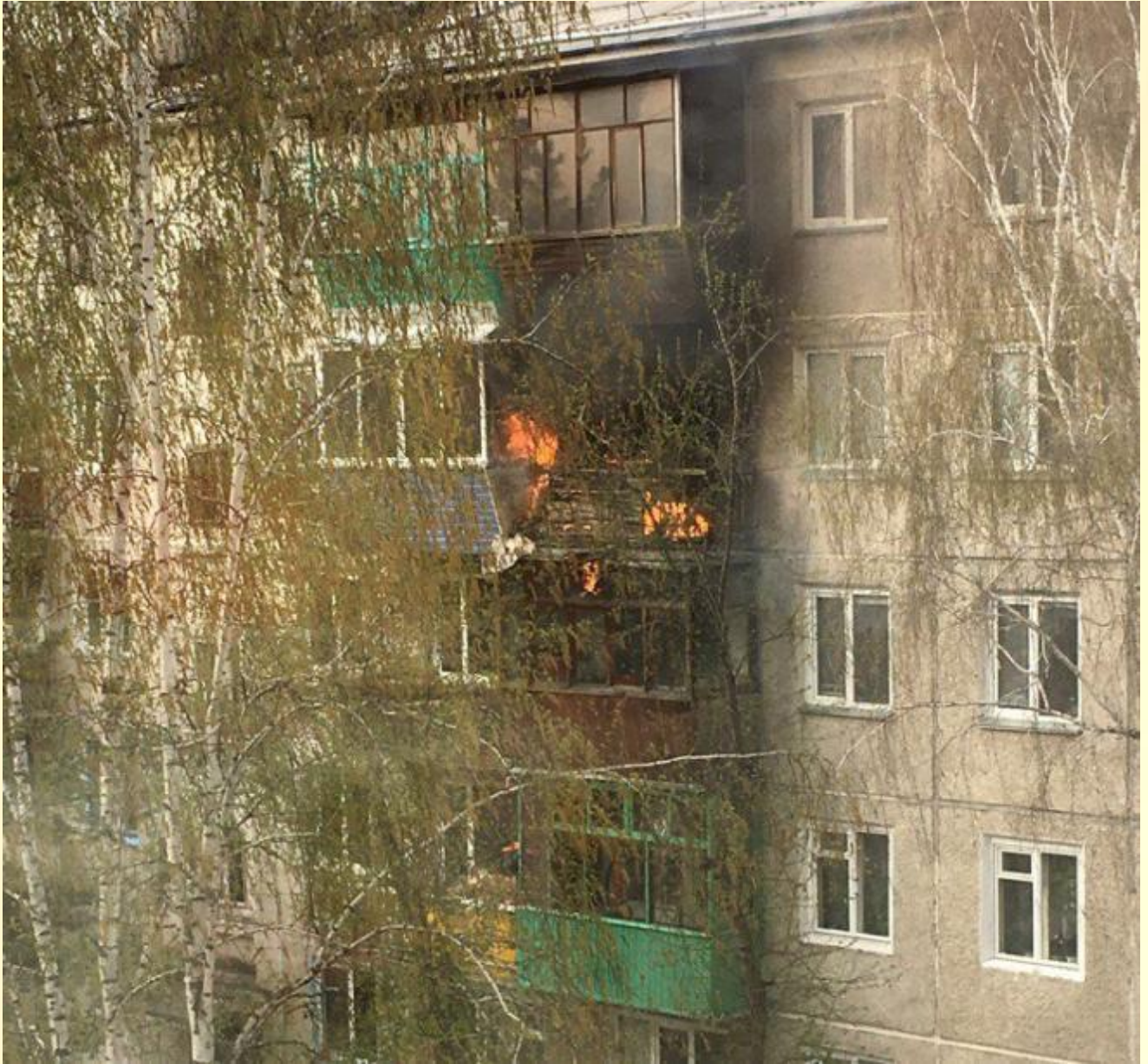
Пожар, произошедший 06.05.2017 г. по адресу: г. Сосновоборск, ул. Труда 1.
